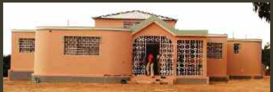
Résidence du personnel, Façade
